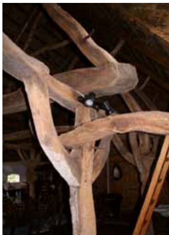
Verbindung der Dachstuhl-Träger
